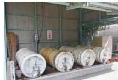
液化アンモニアポンプ及び気化器
